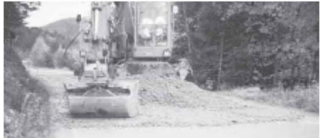
Рисунок 1. Использование гранулированного пеностекла для строительства дорог в Норвегии.
